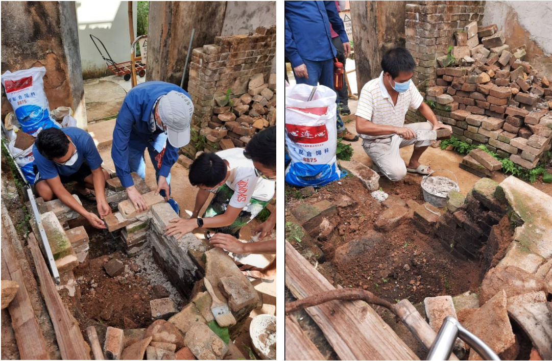
圖 230. 「古建技藝·文化傳承—荔枝窩」磚牆工作坊 446
