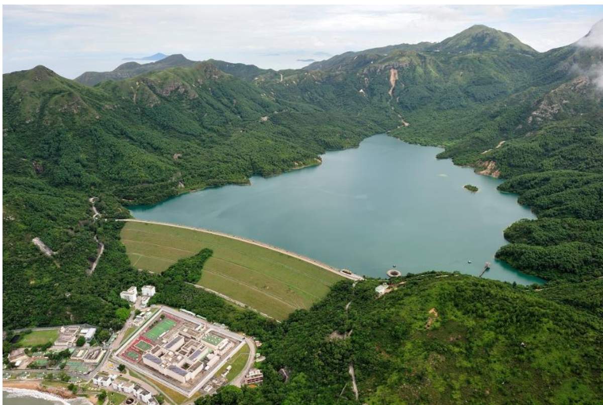
圖 7.62：2017 年石壁水塘及水塘主壩全景 692
