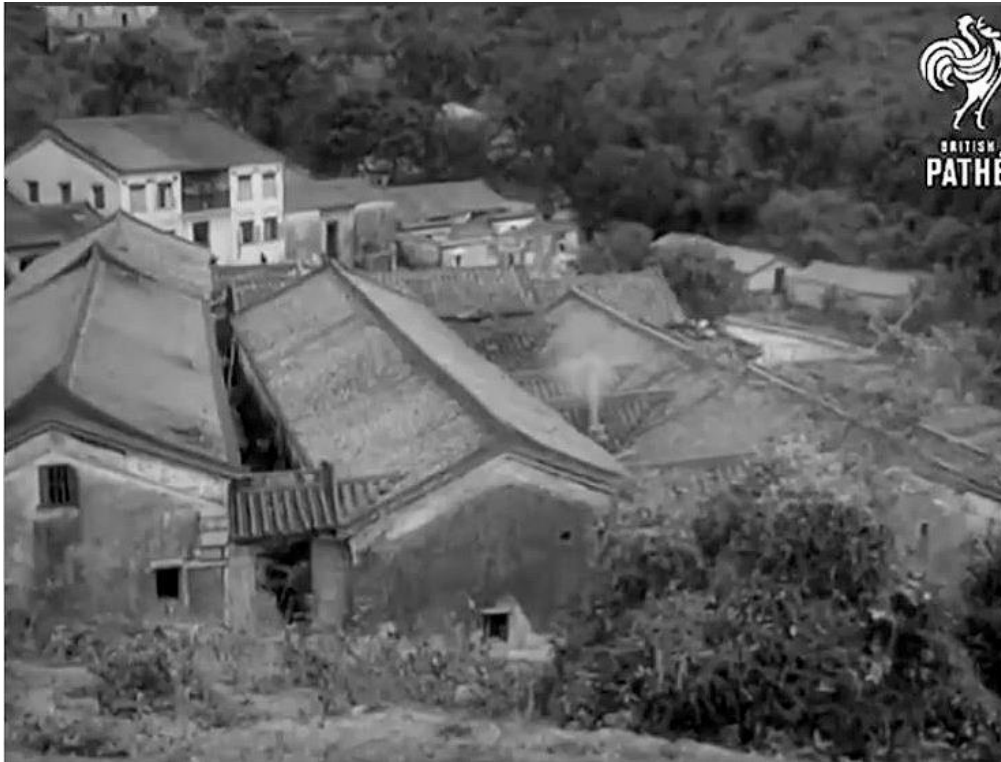
圖 2.11：村落通常依山而建，面向平原和海岸，成排的房屋被窄巷隔開 39 。
