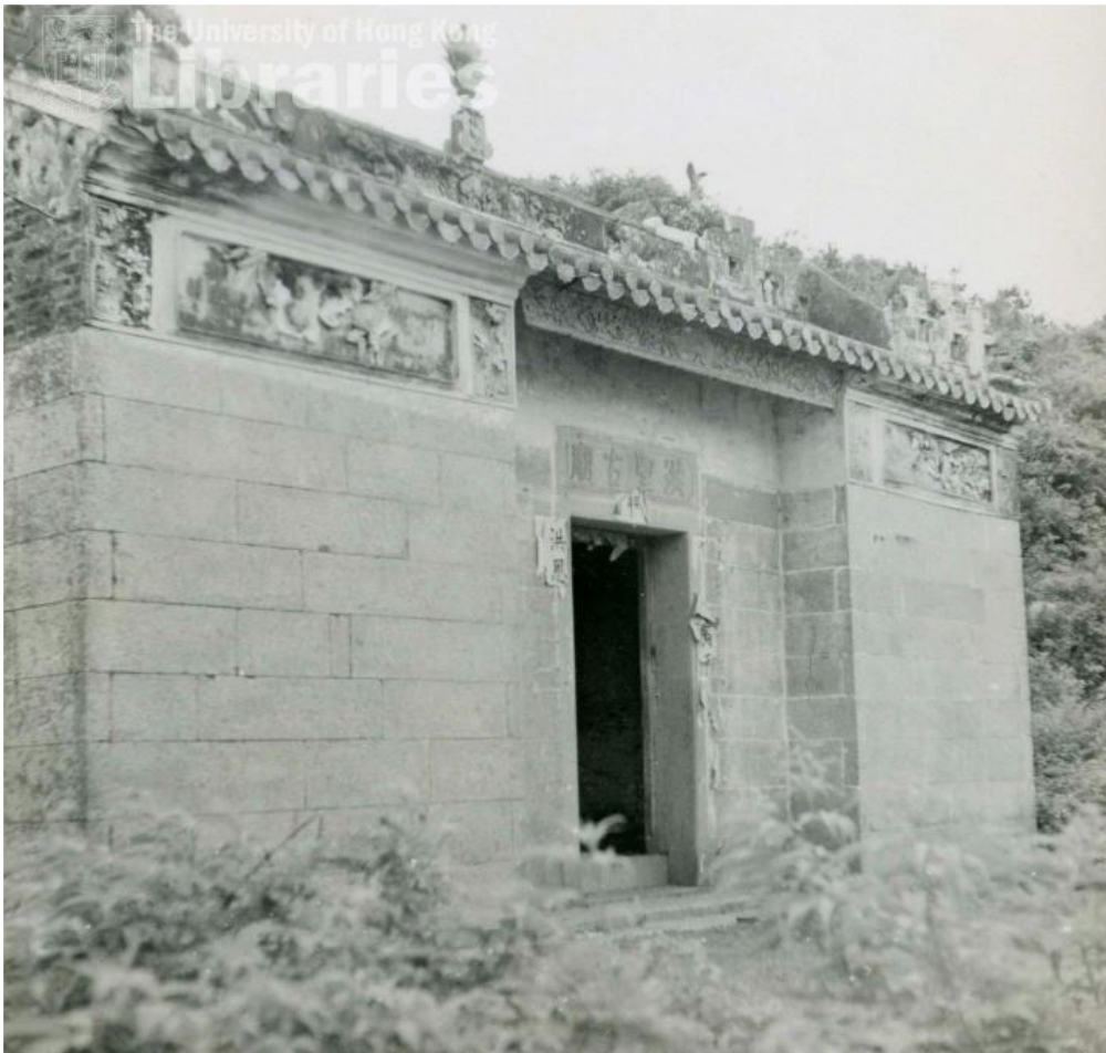
圖3.31：1959年洪聖古廟 169 ：門旁可見殘缺對聯，廟外雜草叢生，推測當時應已開始沒落，但建築整體結構依然完好。
