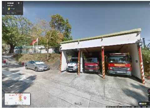
消防局車房側視圖 HB1-02 (Google Maps, 2016)
