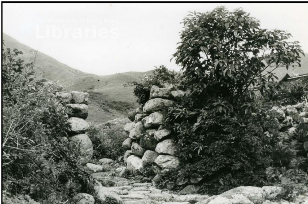
圖 7.50：石壁圍的東閘，牆身用較大的石塊砌成；圖右方石牆背後的廟宇為侯王古廟 678 。
