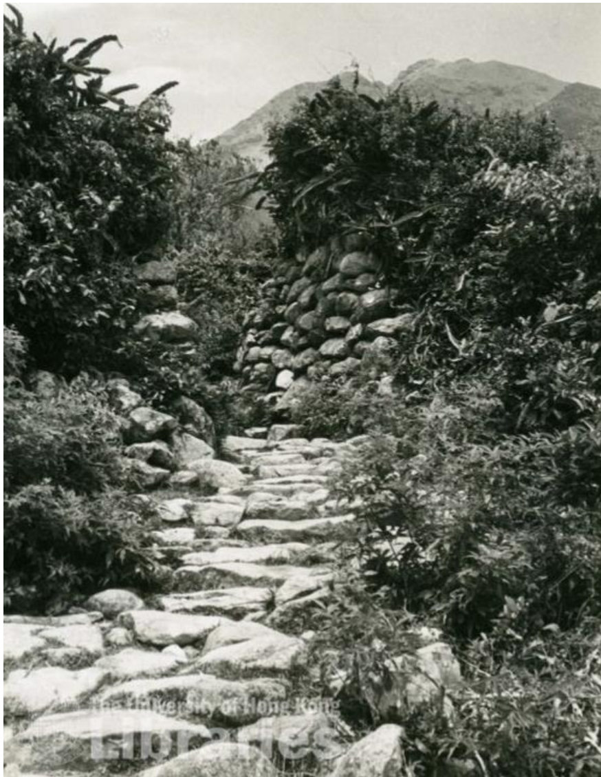
圖 7.48：石壁圍的南閘，牆身用檢自河川的卵石鋪砌而成 676 。
