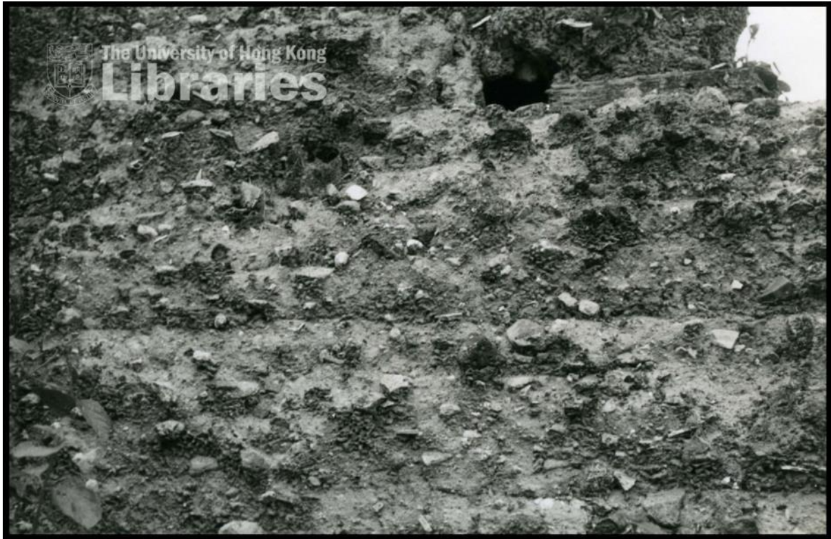
圖 7.92：在荒廢的石壁圍仍可看到部份村屋的牆身，是泥、石塊、貝殼和陶瓷等零片搗碎後壓縮而成 740 。
